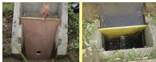
排水口より 小さな穴の 開いた調整 板を設置
