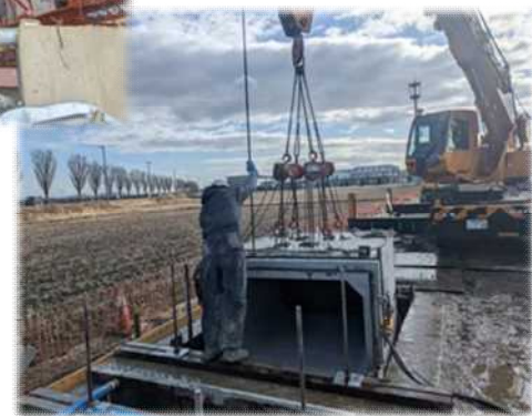
松山千石堀排水区 ⇒ 【R6年度整備】 雨水管渠設置状況
