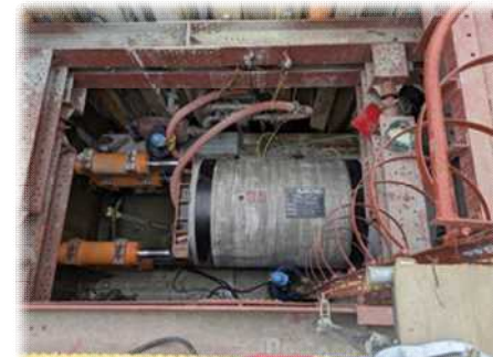
← 古川李埵第1排水区 【R6年度整備】 雨水管渠設置状況
