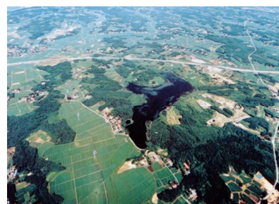
ダム工事着工前の化女沼全景 (宮城県：化女沼ダム工事誌より)
