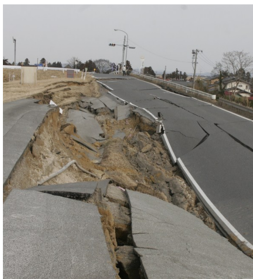
<写真左：路盤面の崩壊 大崎市松山伊場野付近>
