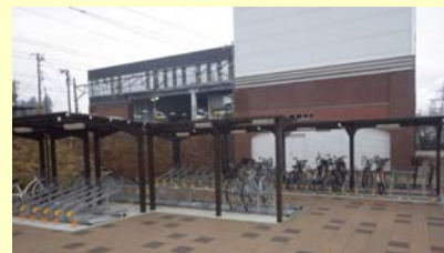
<整備後 (駅東駐輪場：南側)>
