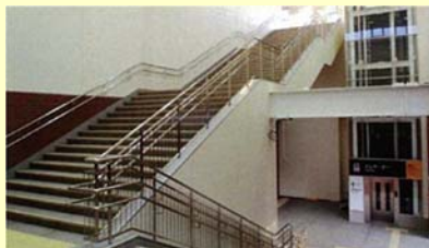
<整備後（自由通路東口階段）>
