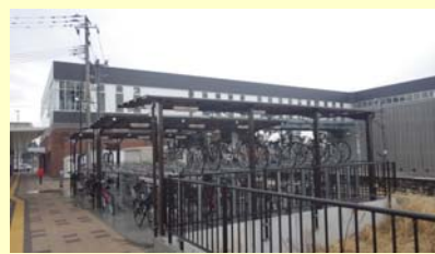
<整備後 (駅西駐輪場：北側)>
