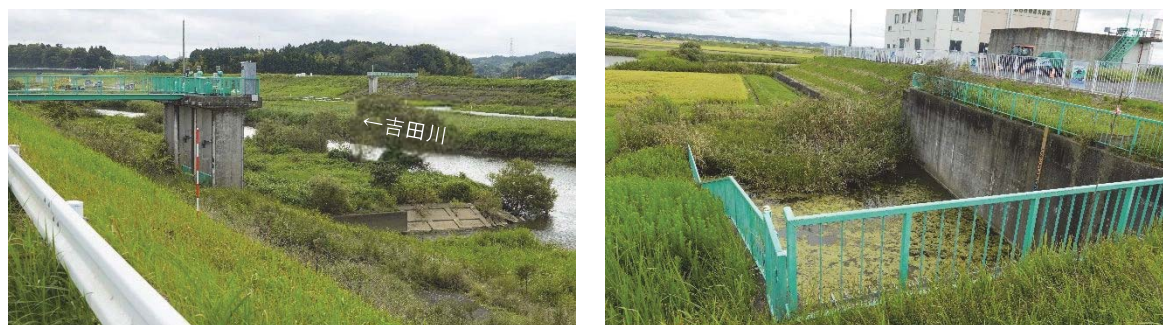
図 3-21 志田谷地排水樋管（非常用排水樋管）
