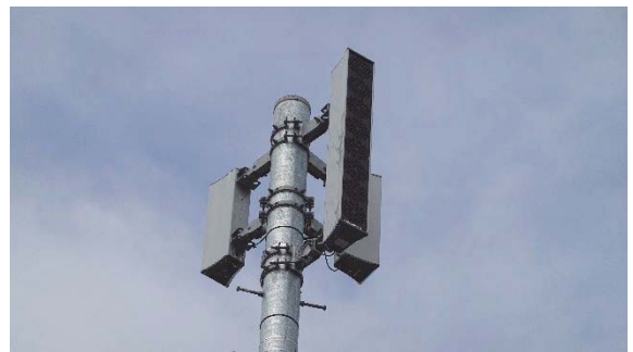
図 3-19 令和元年東日本台風後に増設された屋外子局（中志田集会所）
