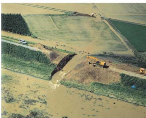
堤防開削による排水（鎌巻地区）
