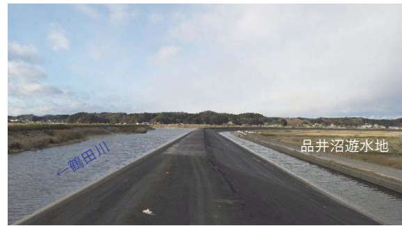
図 3-18 品井沼遊水地越流堤
