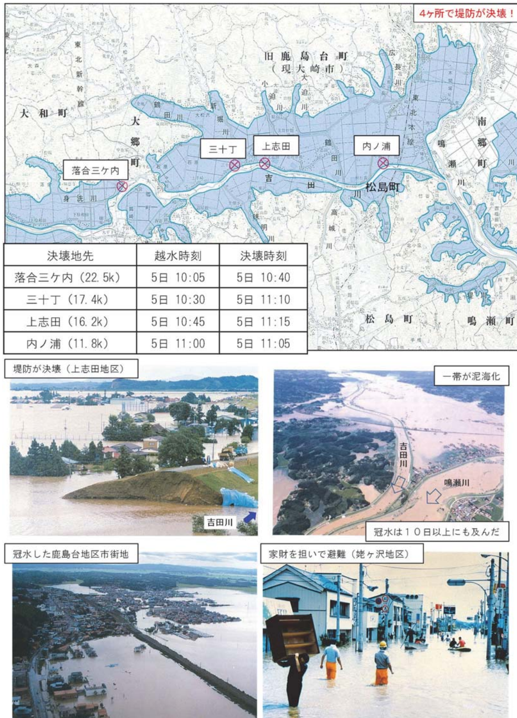
図 3-2 昭和61年8月洪水による被害状況
