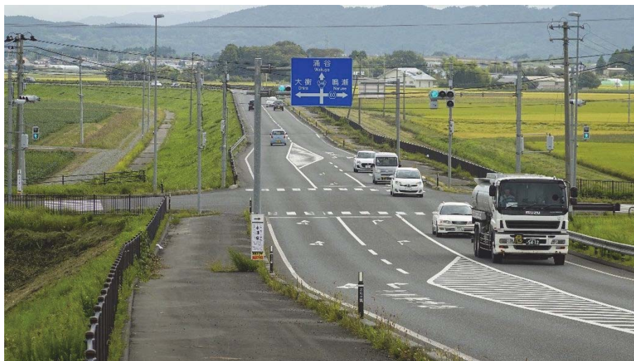
図 3-20 二線堤（国道 346 号バイパス区間）
