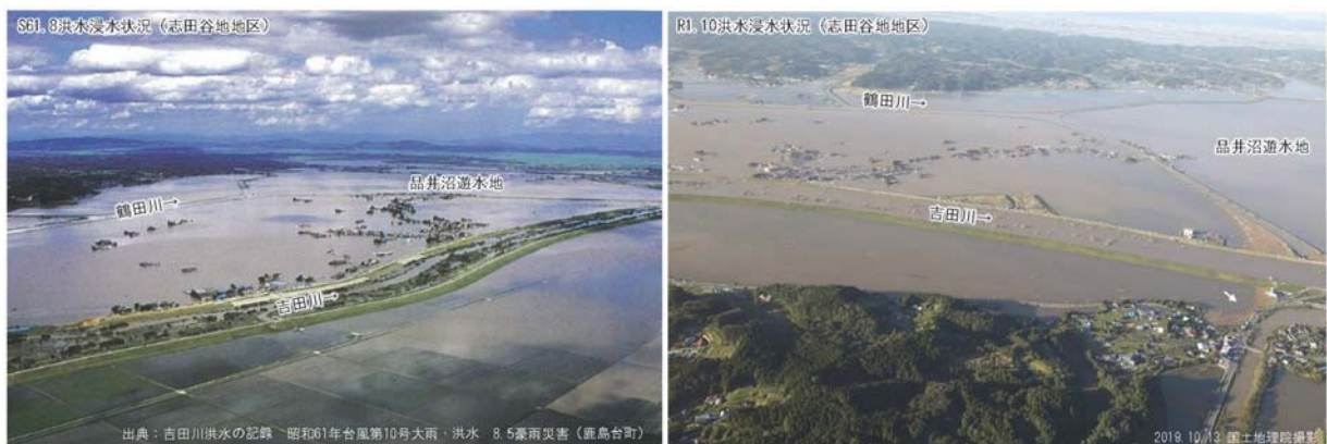
図 3-7 志田谷地地区の浸水状況（S61.8洪水、令和元年東日本台風）
