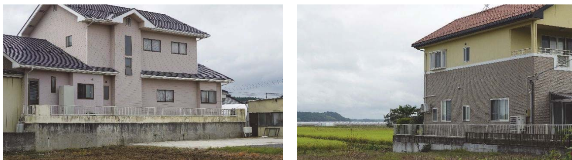
図 3-2 3 宅地嵩上げの様子（志田谷地地区）
