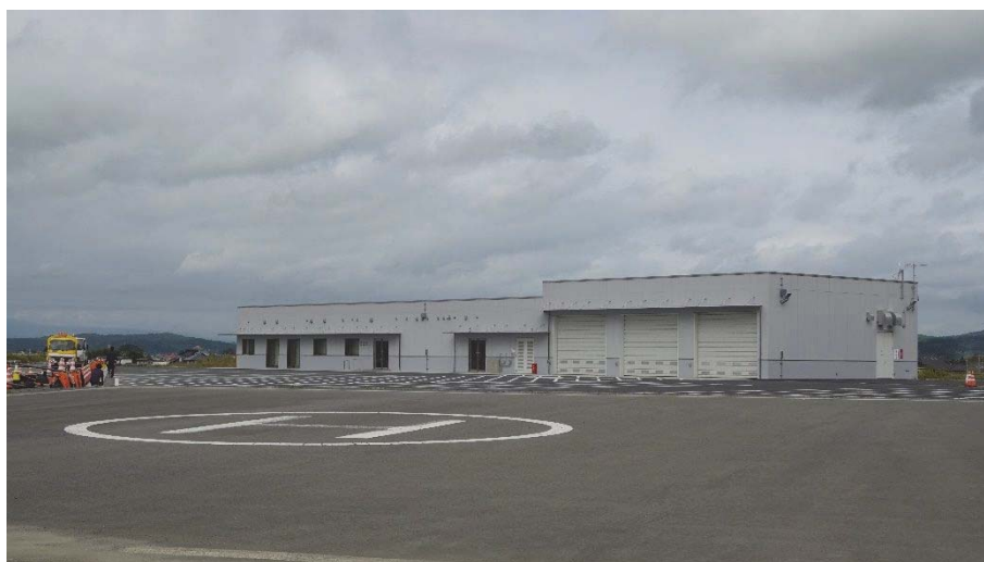
図 3-2 2 志田谷地防災センター
