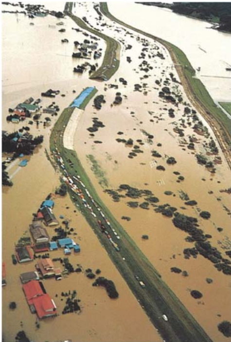
上志田地区堤防決壊地点
