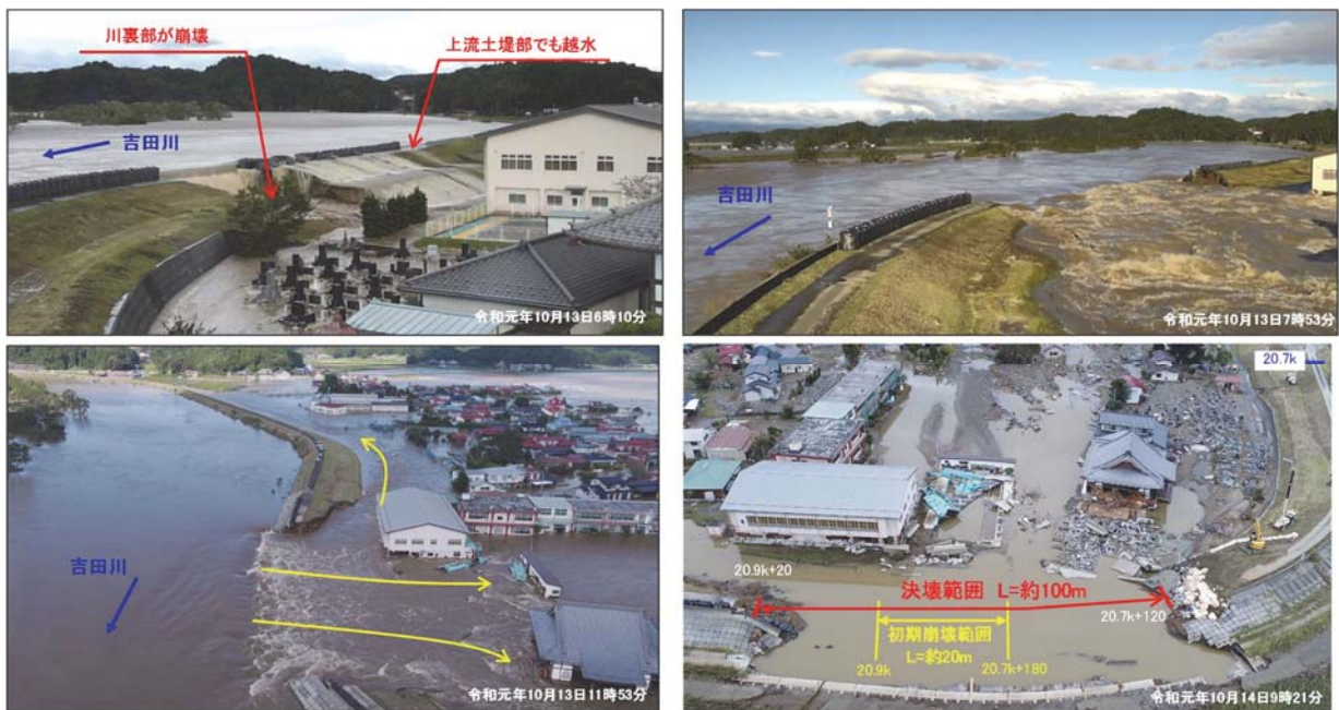
図 3-6 吉田川堤防決壊の様子
