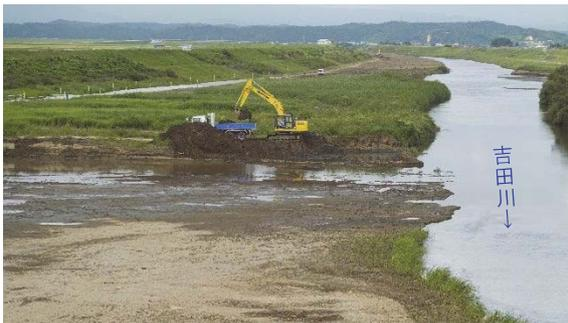
図 3-17 吉田川河道掘削の様子
