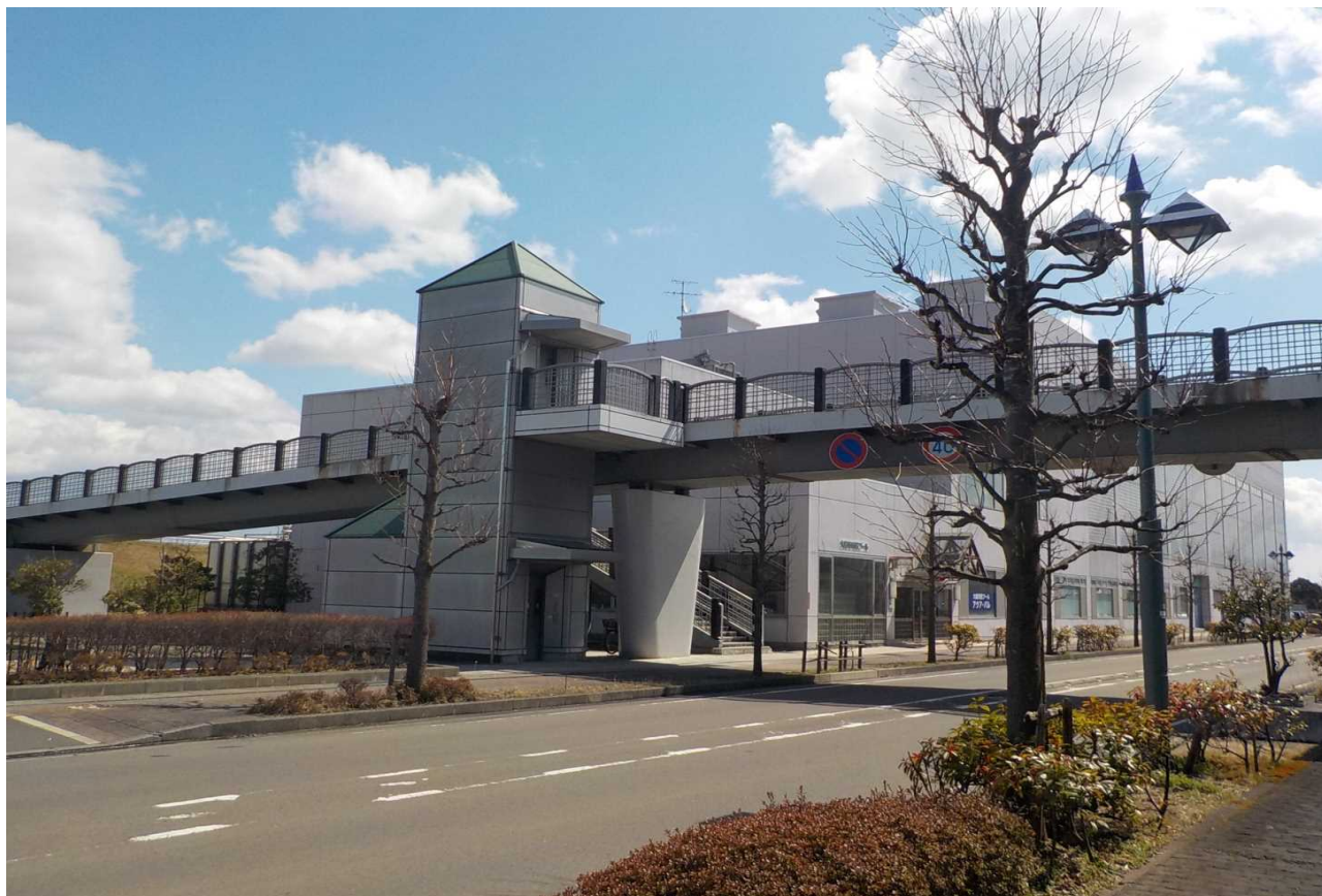
福沼二号線歩道橋(大崎市古川)
