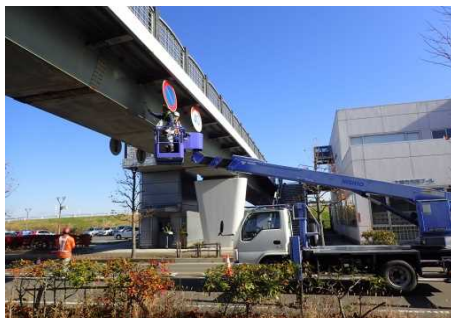
写真-1 高所作業車による点検状況
