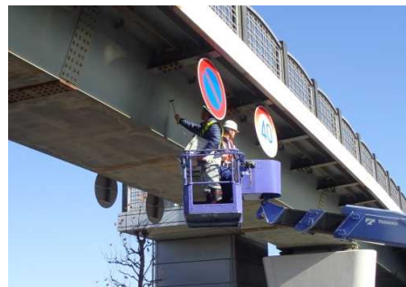
写真-1 高所作業車による点検状況
