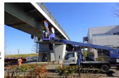
写真-1 高所作業車による点検状況
