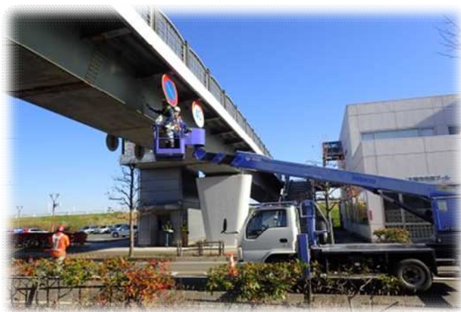
写真-1 高所作業車による点検状況
