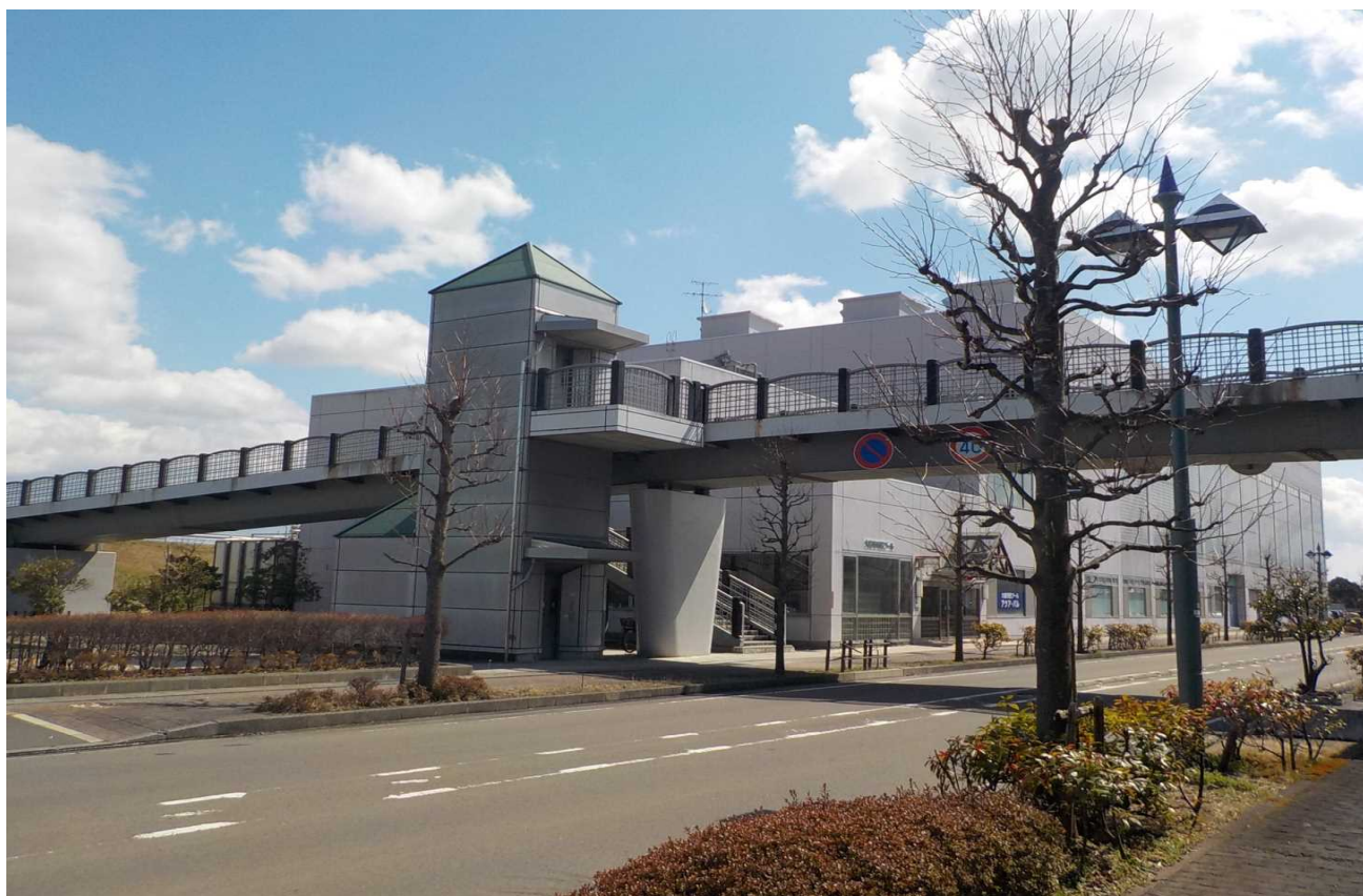
福沼二号線歩道橋(大崎市古川)
