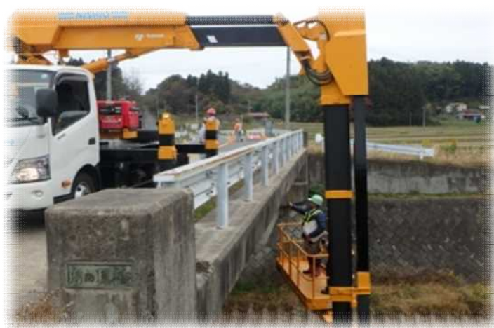
写真-1 橋梁点検車による点検状況
