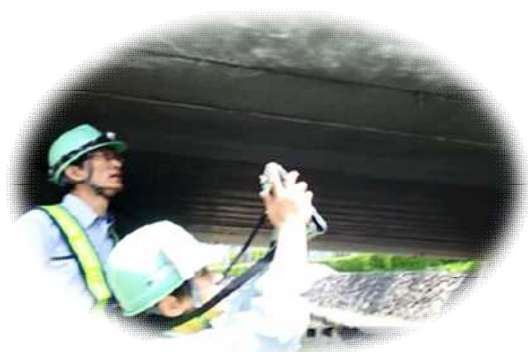
【タブレットによる点検】
