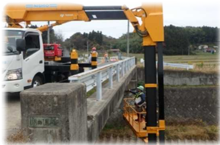
写真-1 橋梁点検車による点検状況
