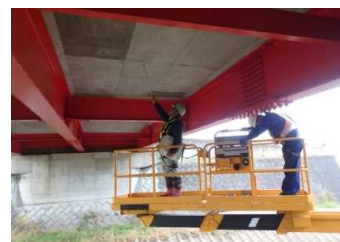
写真-1 橋梁点検車による点検状況
