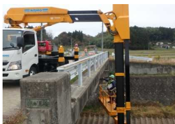
写真-1 橋梁点検車による点検状況
