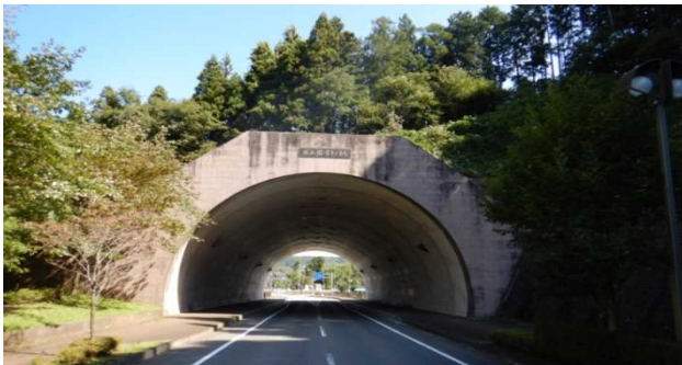
写真-1 城山遊・学トンネル
