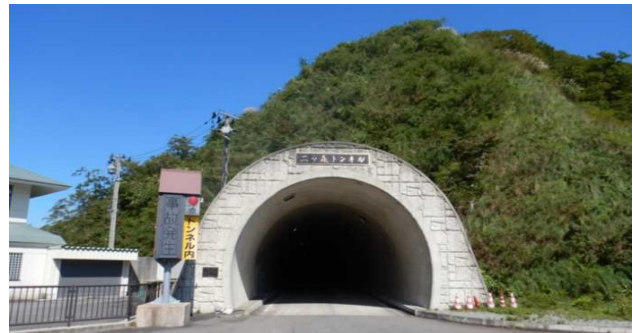
写真-2 ニッ森トンネル
