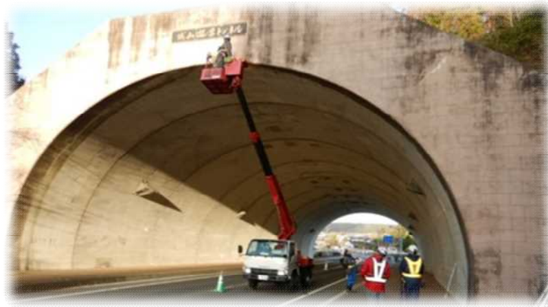
写真-3 トンネル点検車による点検状況
