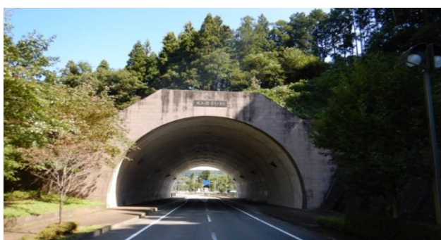
写真-1 城山遊・学トンネル
