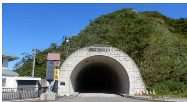
写真-2 ニツ森トンネル
