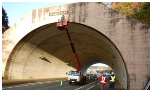
写真-3 トンネル点検車による点検状況
