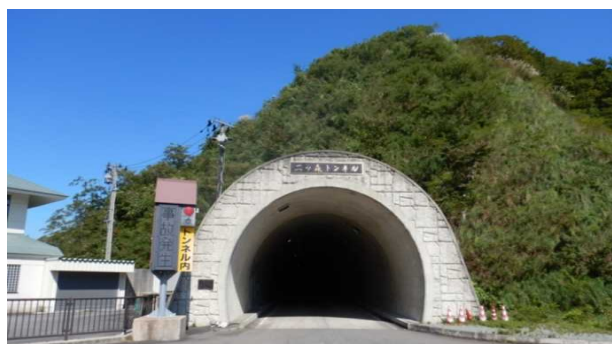
写真-2 ニッ森トンネル
