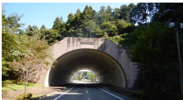
写真-1 城山遊・学トンネル
