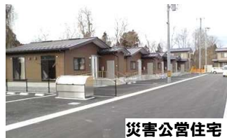
災害公営住宅
