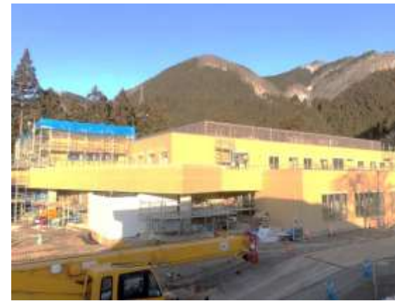
(写真) 鳴子温泉分院進捗状況 2月12日撮影
