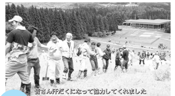
運搬車で運ばれた土石の山。びっくりする量です
