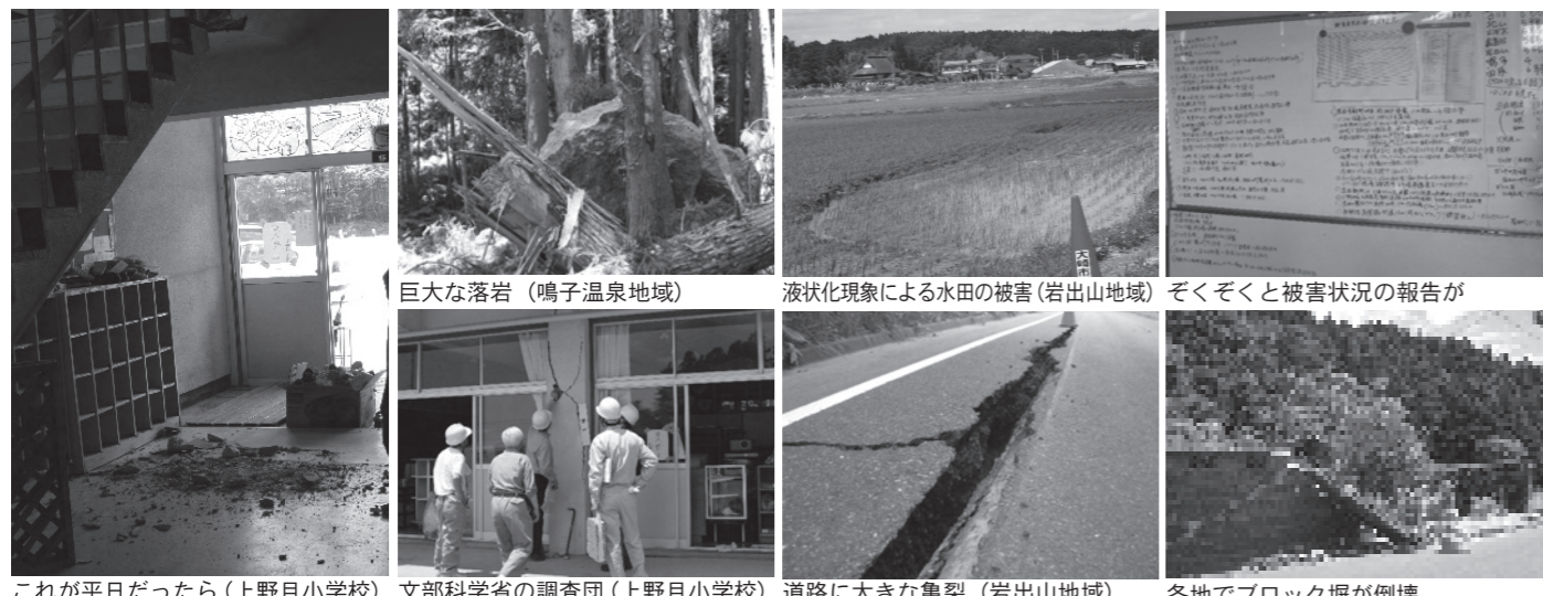
これが平日だったら(上野目小学校) 文部科学省の調査団(上野目小学校) 道路に大きな亀裂(岩出山地域) 各地でブロック塀が倒壊
