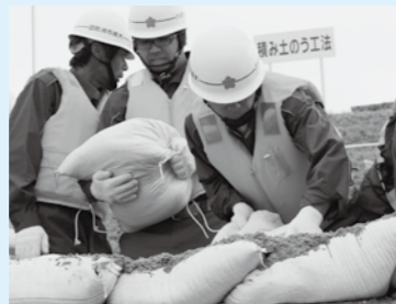
松山支団員が、河川のはんらんを防止するため、土のうを積み上げます
