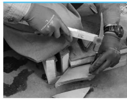
現在、瓦の加工には電動器具が用いられますが、1級技能士は、「たがね」と「瓦ハンマー」を自在に操り、意のままに、瓦を加工する技術を身につけています。
