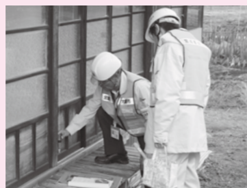
二人一組で手順を確認しながら、建物の傾きを測定しています
