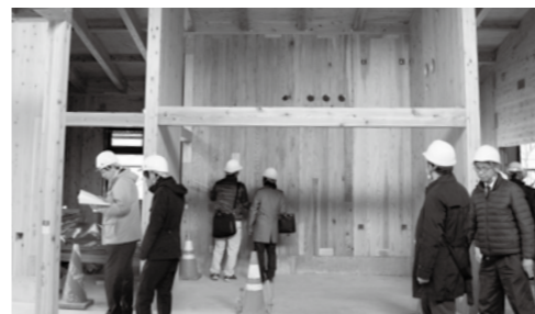
▲大崎市産スギ材を使用し建築中のクラブハウス内部を見学する参加者
