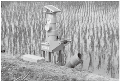
水田の持つ雨水貯留能力を活用し、洪水被害を緩和する「田んぼダム」
