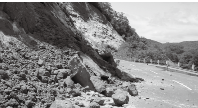
▲岩手・宮城内陸地震(平成20年6月14日発生)で受けた被害(鳴子温泉地域)
