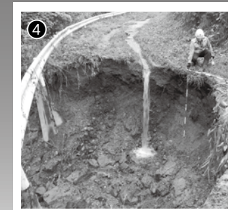
①②名蓋川の堤防が決壊し、浸水被害にあった古川地域矢目地区③冠水した松山小学校前交差点④路体が流出した林道絵図沢館山線(岩出山地域)⑤浸水被害にあった畑(古川地域)
