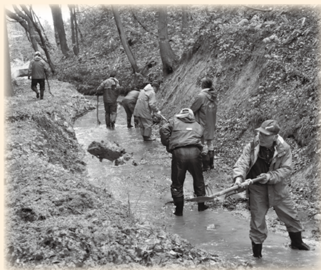
▲開水路の土砂払い作業
