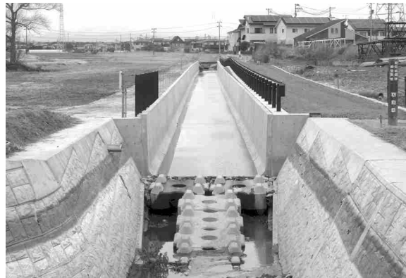
古川地域では、大江川上流の排水路整備工事を行っています。
