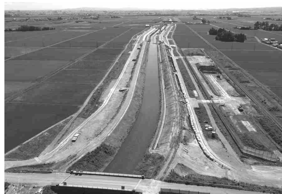
令和9年3月の完成を目指し、県による名蓋川の河道拡幅、堤防のかさ上げが行われています。
