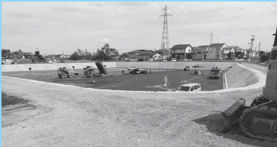
写真：施工中の巳待田第2調整池（JR 東北本線側）
