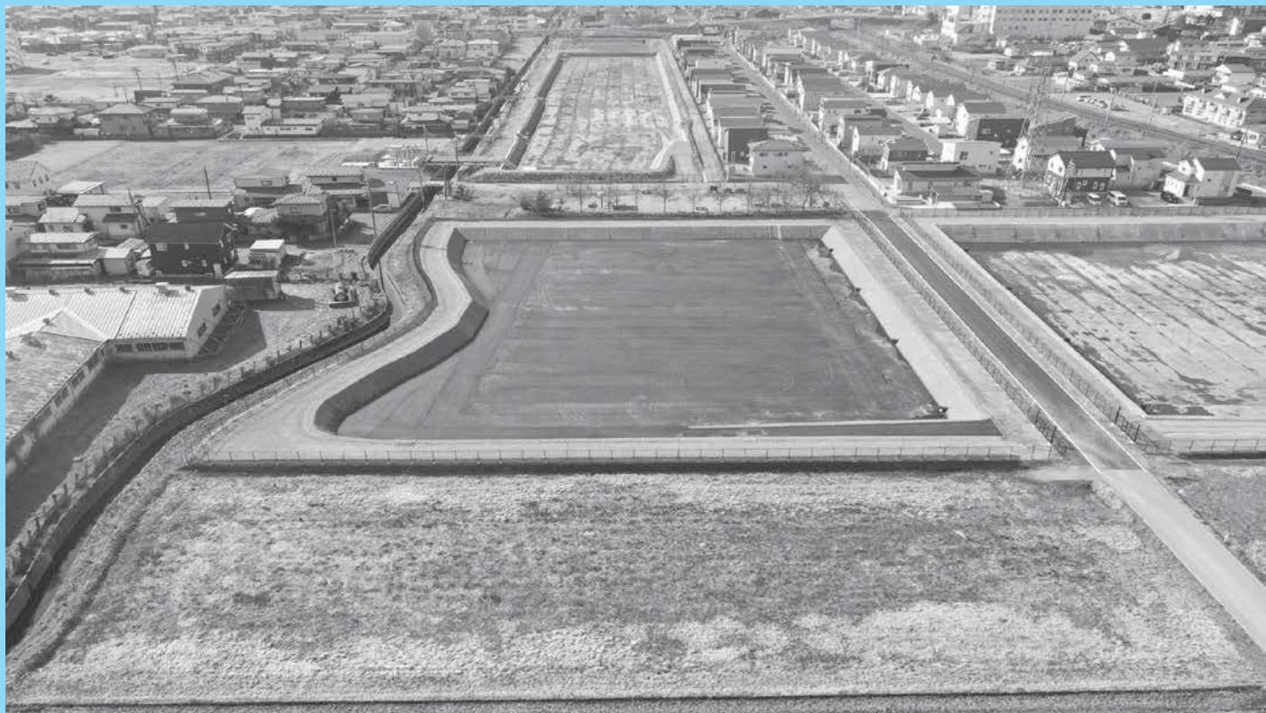
写真：完成した巳待田第2調整池（写真中央）
