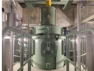
増設された3号雨水ポンプ口径1,500mm
