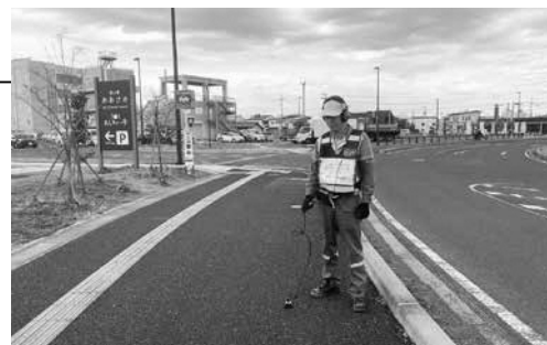
漏水調査状況
