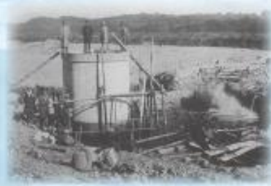
（水源改良工事）
