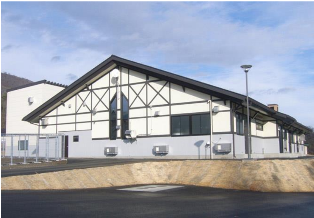
鳴子温泉地域 青山浄水場
