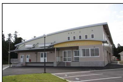
大崎南学校給食センター
