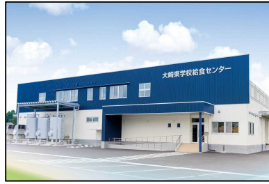
大崎東学校給食センター
