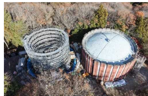
施工状況（令和7年12月現在）
