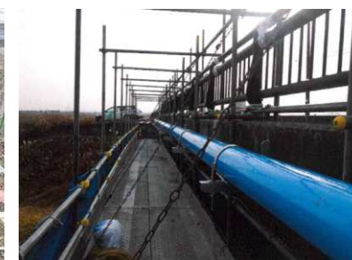
橋梁添架管布設状況
