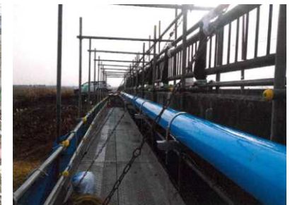
橋梁添架管布設状況
