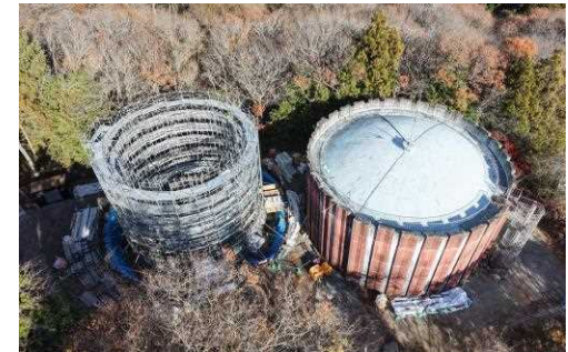
施工状況（令和7年12月現在）
