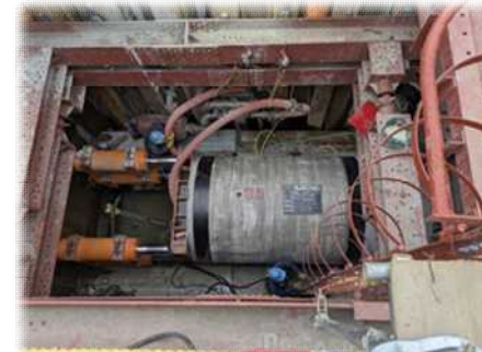
← 古川李塚第1排水区 【R6年度整備】 雨水管渠設置状況
