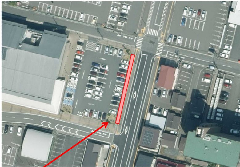
大崎図書館東側第1駐車場のフェンス
