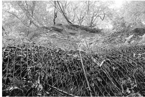
鳴子峡の落石防止工事を終えた法面
