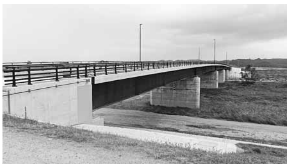
新志田橋の建設現場 (10.19現在)
