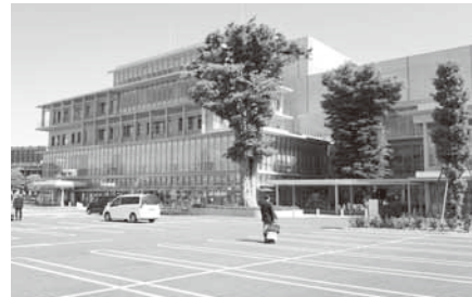
秩父市役所新庁舎全景
