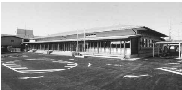
完成した田尻総合支所新庁舎
