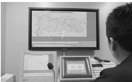
防災行政無線親局（松山総合支所）
