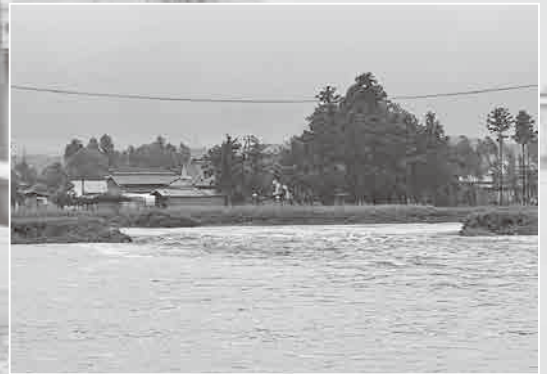
決壊した名蓋川堤防（古川地域矢目）
