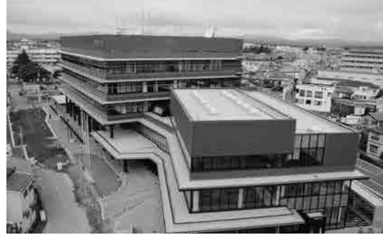
新市建設計画最後の市役所本庁舎建設は完了
