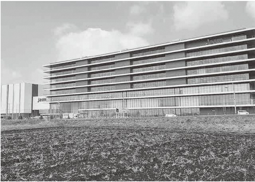
熊本県に進出した半導体企業 (JASM 第1工場)
