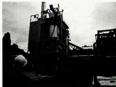
[循環流動層ボイラー]
