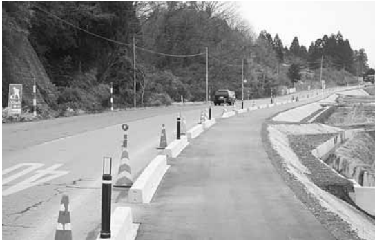
歩道を整備する市道鳴子鍛冶谷沢線
