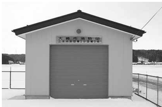
消防ポンプ置き場
