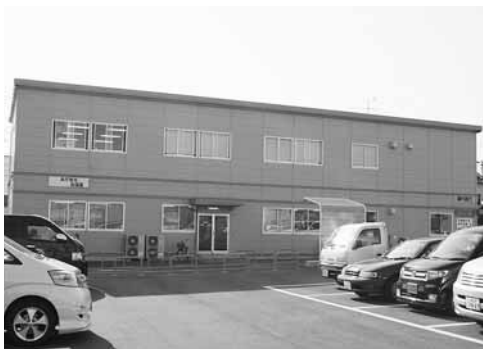
本庁舎北会議室
