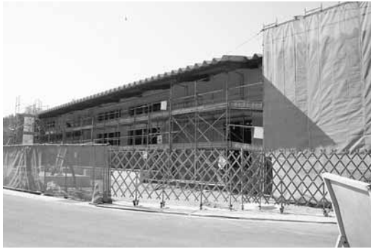
建設中の仮称大崎南学校給食センター
