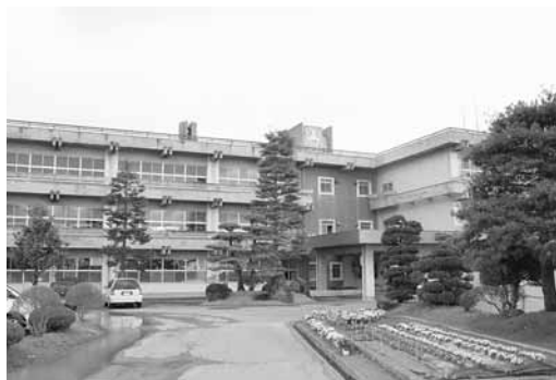
耐震改修を待つ古川西中学校
