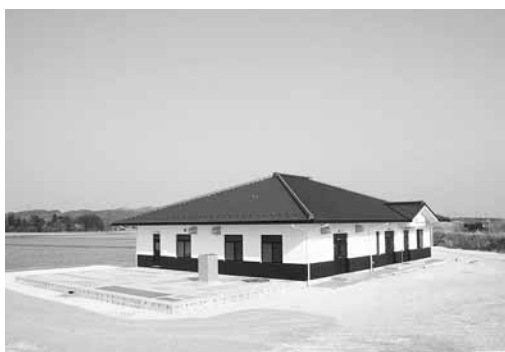
田尻第2地区農業集落排水処理施設
