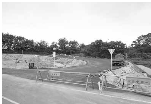
工事が進む三本木スマートインターチェンジ
