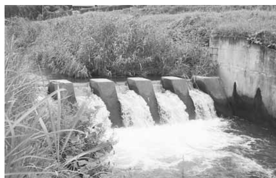
取水施設（南沢樋渡堰）
