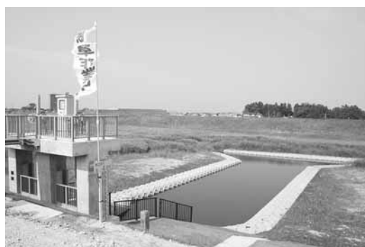
李埴雨水排水ポンプ場現場
